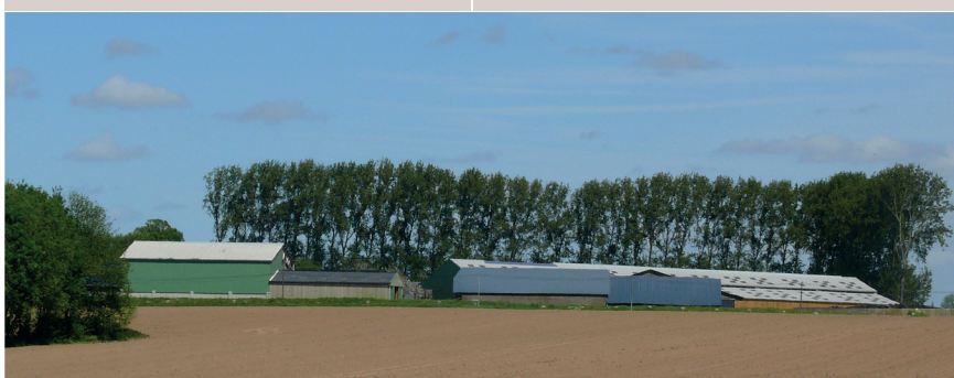
Les toits de couleurs claires et la multiplicité des coloris de façades nuisent à l'intégration des bâtiments agricoles.
