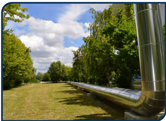
Réseau de vapeur au départ d'ECOSTU'AIR (thermique)
